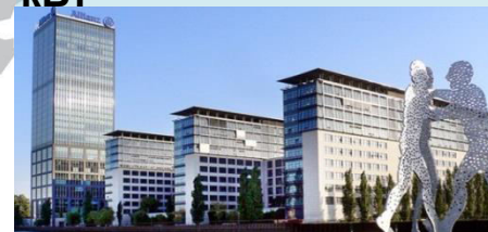
Комплекс административных зданий, 4 220 кВт
