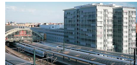
Железнодорожный вокзал, 1 250 кВт
